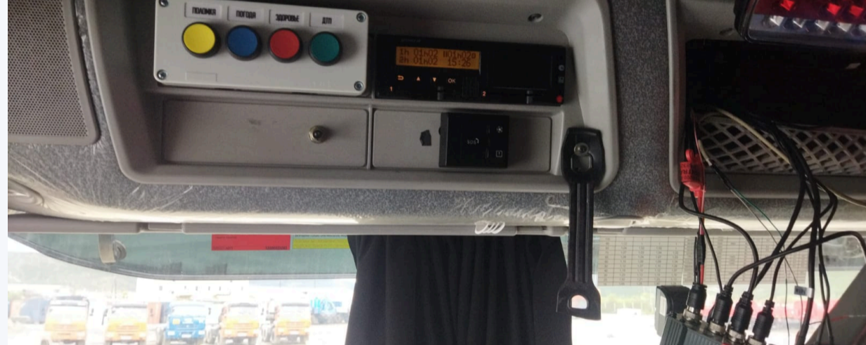
Un système d'alerte conducteur à quatre boutons installé à l'intérieur de la cabine
