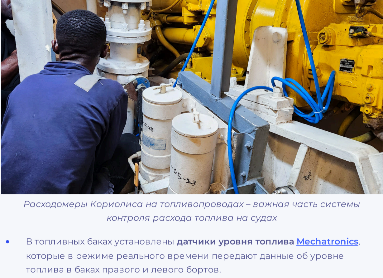
Расходомеры Кориолиса на топливопроводах – важная часть системы контроля расхода топлива на судах
