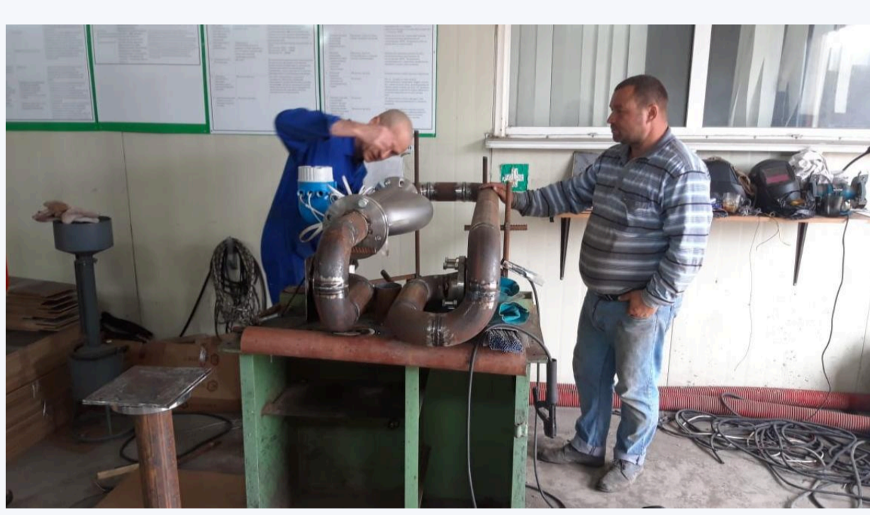
Soudage de tuyaux par gabarits dans l'atelier
