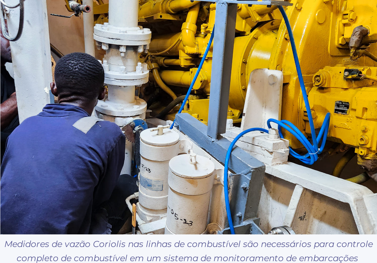
Medidores de vazão Coriolis nas linhas de combustível são necessários para controle completo de combustível em um sistema de monitoramento de embarcações
