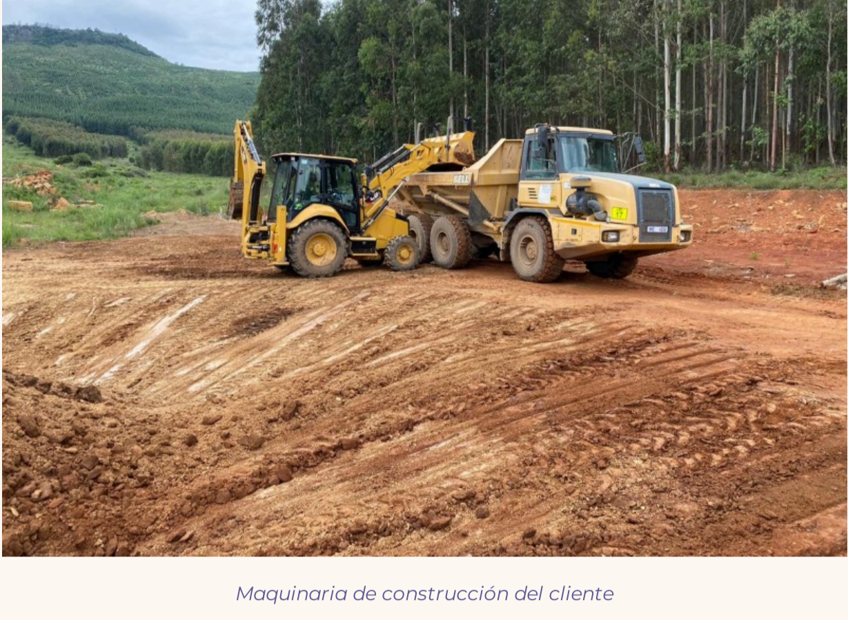
Maquinaria de construcción del cliente
